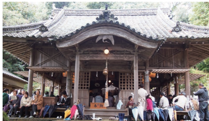
修復以前の春日神社。壁の取り外しができ住民が集うことができる。
