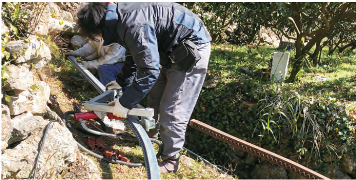
特殊な機械でレールを曲げて石垣に沿うように
